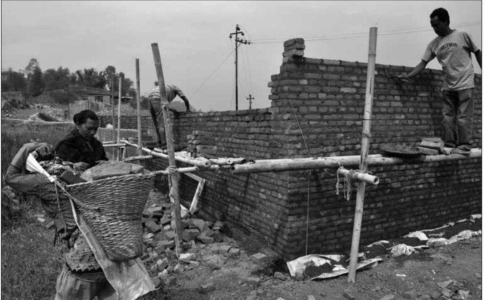
Der svedes bravt på byggepladsen, hvor fire-fem nepalesiske arbejdere i disse uger er i gang med at opføre Children's Welfare Center's nye kostald.
